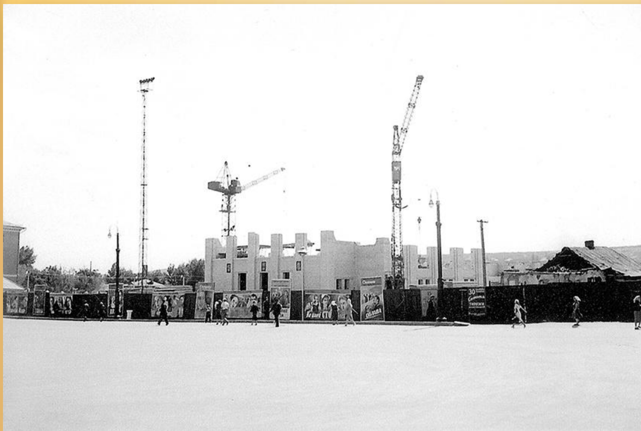
Строительство драматического театра. Начало 1960-х годов
